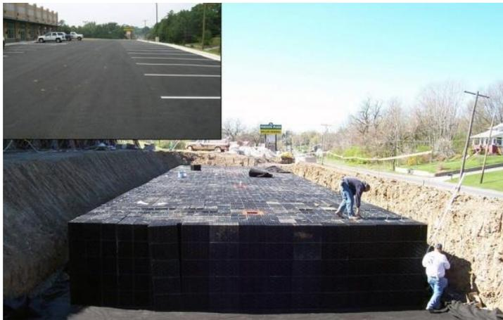
*Esempio di invaso sotterraneo con celle in materiale plastico*
